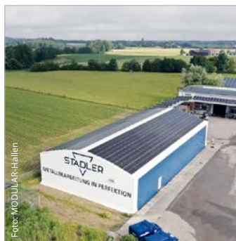
Temporäre Halle mit PV-Anlage
