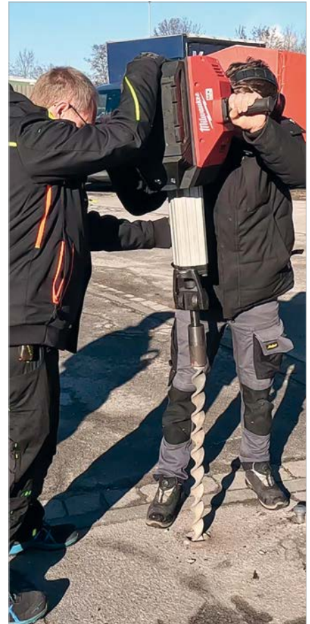
Der Spirafix-Anker erreicht bei nur 750 mm Länge eine leicht größere Mantelfläche als ein klassischer Erdnagel.
